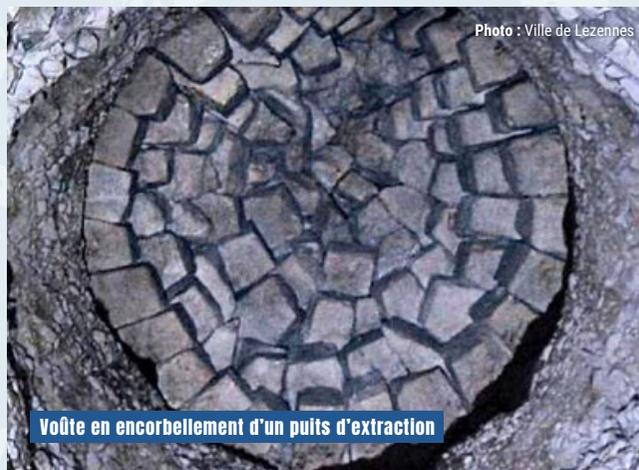
Voûte en encorbellement d'un puits d'extraction
